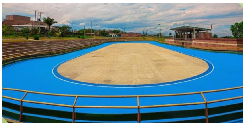
Ilustración 77 Culminación Obra de Mantenimiento y Adecuación del Patinódromo
