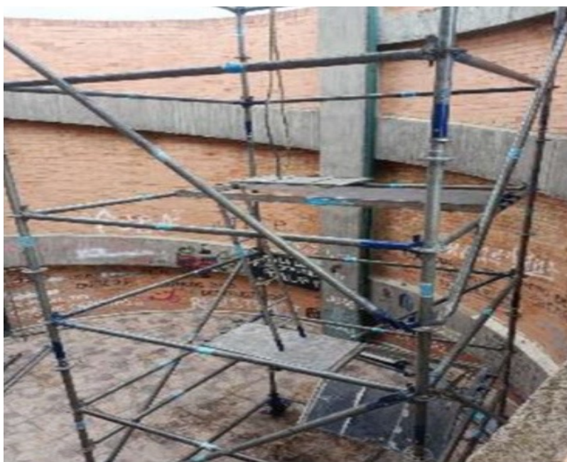
Ilustración 58 Infraestructura de Trabajo en Alturas FA-OCO-040 2024
