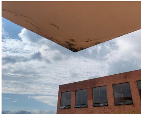
Figuras 3. Cuarto nivel Bloque F Fuente: Propia
