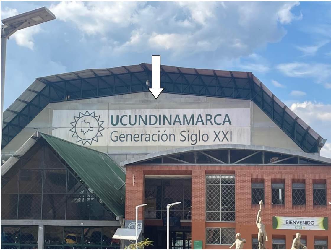
Foto de apoyo área en fachada a intervenir
