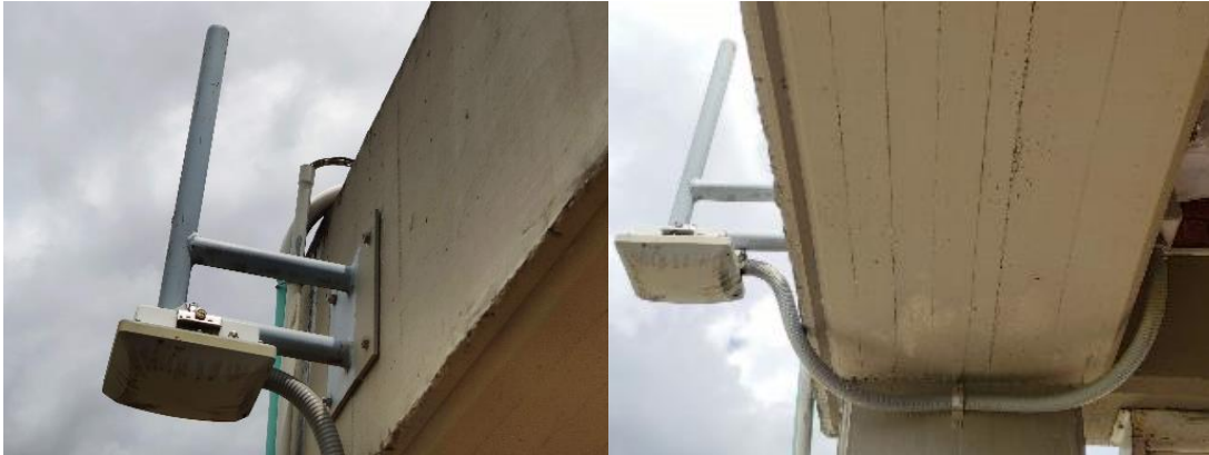
Imagen 13, Soporte para AP exteriores
