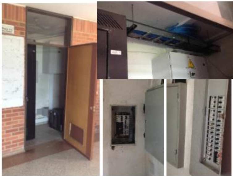
Imagen 2. Estado actual CD1 - Bloque A
