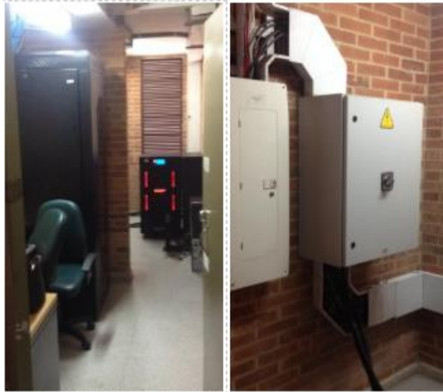
Imagen 7. Estado actual TR2 - Bloque B
