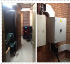
Imagen 7. Estado actual TR2 - Bloque B
